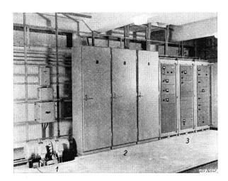
Fig. 12. Fernwirk-Einrichtungen in einem ferngesteuerten Unterwerk.
