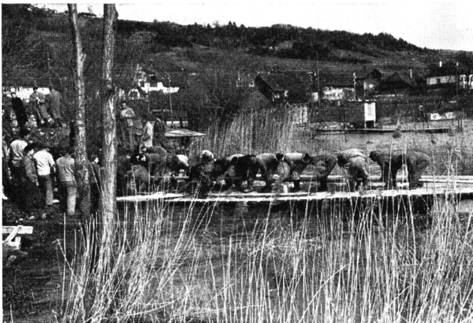
Fig. 4. Kein Tausendfüssler – sondern Männer, die mit behenden Händen das ausgezogene Kabel in Zoreskanäle legen und diese verschrauben
