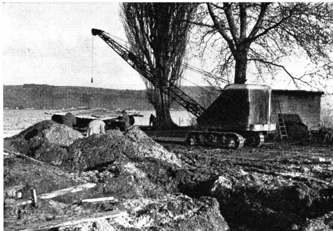
Fig. 1. Die Kabel-Baustelle in Meyriez
