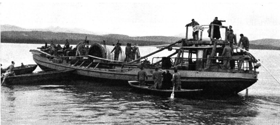
Fig. 10. Mitten im See. Man beachte links die Militärpontons, die als Steuerhilfen dienen. Auf der Kommandobrücke amtiert ein Ingenieur der Kabelwerke Brugg AG am Telemeter als Navigator
