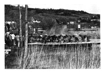
Fig. 4. Kein Tausendfüssler – sondern Männer, die mit behenden Händen das ausgezogene Kabel in Zoreskanäle legen und diese verschrauben
