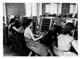
Fig. 8. Central manuel de Zurich, équipé entièrement de positions sans cordons
