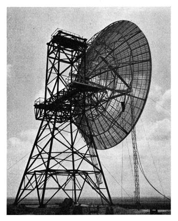
Fig. 1. Installation der Parabol-Antenne von 20 m Durchmesser in Sardinien
