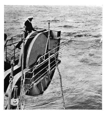
Fig. 14. Pose du câble par a poulie de poupe
