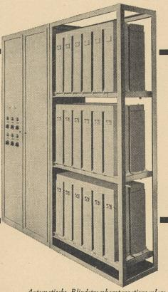
Automatische Blindstromkompensationsanlage, Blindleistung 240 kVar, Spannung 380 V $\sim$
