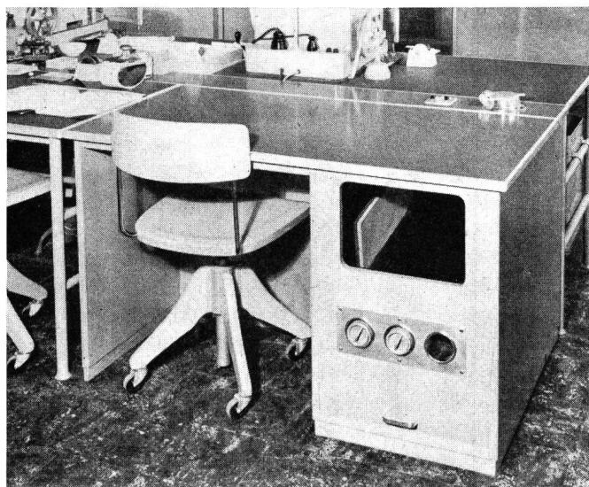
Fig. 23. Send- und Empfangsstelle der Stadtröhrenpost mit horizontaler Büchsen-Ausschleusvorrichtung im Telefon- und Telegraphenbüro in Olten
