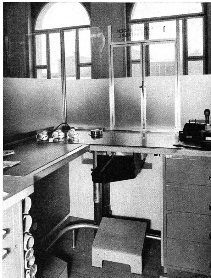
Fig. 16. Schalter im Geldamt Aarau mit horizontalem Hausrohrpost-Empfänger unter der Schalterplatte
