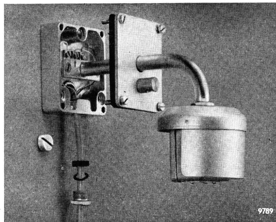
Fig. 7. Aussenfühler der Zentralheizungsregulierung «Sigma» mit abgeschraubter Deckplatte
