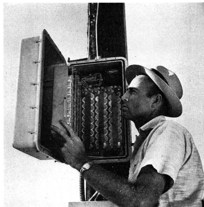
Fig. 4. Die überschüssige elektrische Energie aus der Sonnenbatterie wird in Speicherbatterien gesammelt und steht als Reserve für den Nachtbetrieb sowie für Schlechtwetterperioden dem Telefonsystem zur Verfügung. L'énergie en excédent est conduite à des batteries d'accumulation où elle reste en réserve pour la nuit et les périodes de mauvais temps
