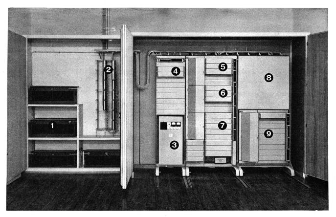
Fig. 7. Hauszentrale für 6 Amtsleitungen und 30 Zweiganschlüsse (Wandmontage)
