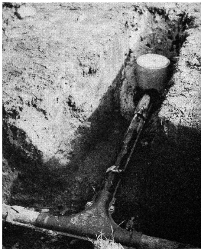
Fig. 4. Fertig montierte Magnesumanode. Vorne sieht man den Anschluss der Anode an das Kabel, im Hintergrund direkt über der Anode ein Standrohr mit einer Trennstelle, in der jährlich einmal der Strom kontrolliert wird
