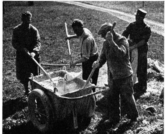
Fig. 3. Mischen der Bentonitmasse für eine Magnesiumelektrode
