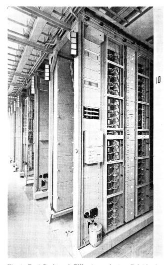
Fig. 5. Zwei Buchten 2. TW mit zugehöriger Relaisbucht. Links: Diversbucht mit Antriebsmotor
