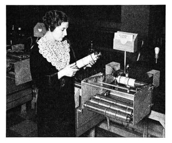
Fig. 5. Faksimileapparate für Hauptämter und grössere Filialen mit automatischer Ladung der Walzen Appareils fac-similés à charge automatique des cylindres pour offices principaux et grandes succursales
