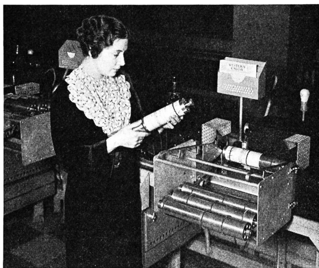
Fig. 5. Faksimileapparate für Hauptämter und grössere Filialen mit automatischer Ladung der Walzen
