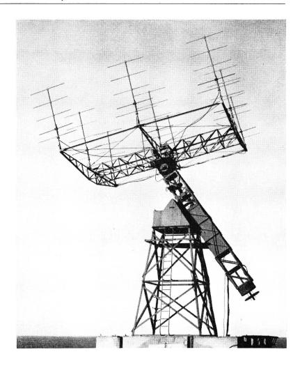
Fig. 6. Yagi-Antennensystem der australischen Forschungsgruppe in Sidney für  $\lambda\,=\,3\,\,\mathrm{m}$
