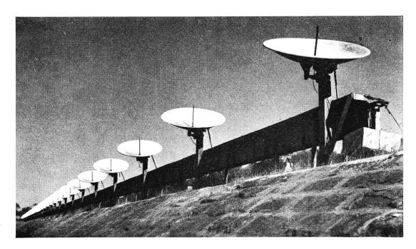
Fig. 13. Gesamtansicht des Vielfach-Interferometers für  $\lambda = 21$  cm
