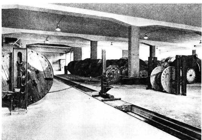
Fig. 3. Kabellängen-Messeinrichtung einer Telephondirektion.
