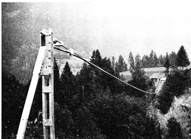
Fig. 16. Mast mit eingesetzter Sicherheitsbride Mât avec bride de sécurité montée
