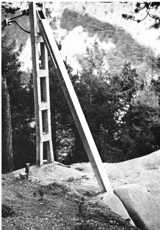
Fig. 3. Normalmast, Höhe 3 m Mât normalisé, hauteur 3 m
