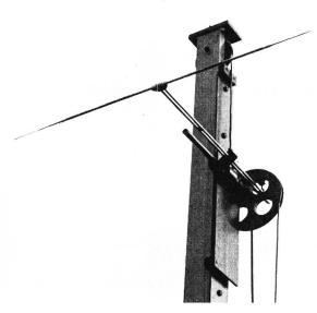
Fig. 6. Détail du chariot porte-antenne
