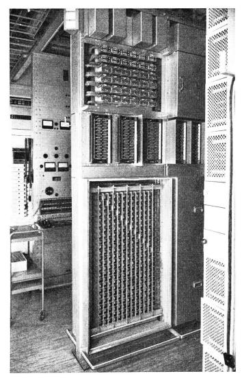
Fig. 28b. Baie de têtes de câbles avec réseau d'équilibrage et bobines translatrices
