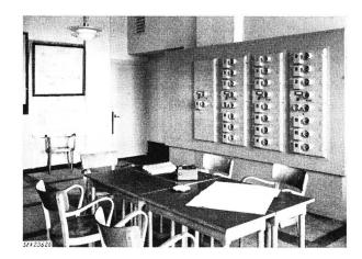
Fig. 7. Fernmessanlage nach dem Kondensatorumladeverfahren mit Tonfrequenzübertragung
