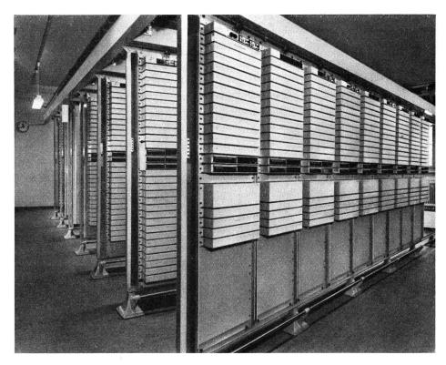
Fig. 7. Relaisgestelle des Amtsteiles — Bâtis de relais côté réseau
