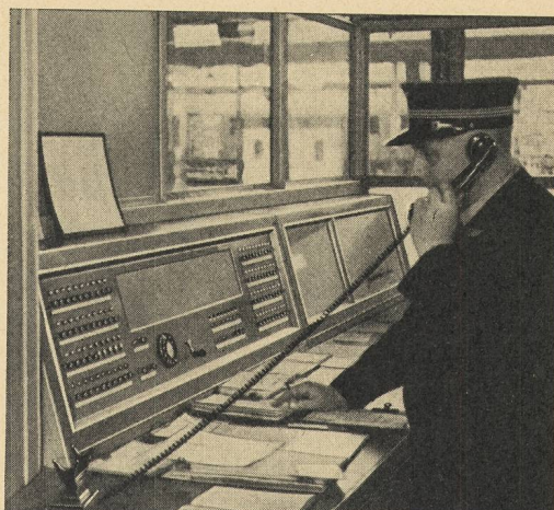
ALBIS-Telephon-Anlage bei den SBB
