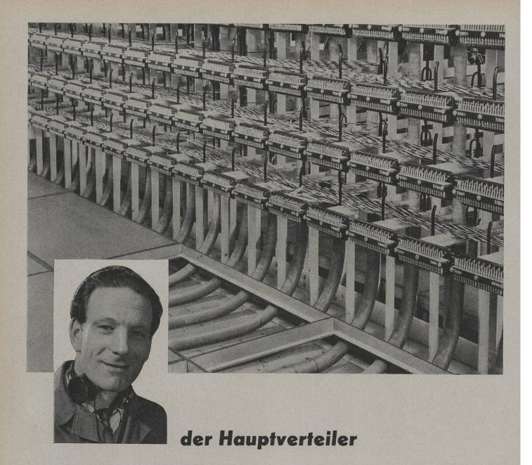
Der Hauptverteiler ist das Nervenzentrum der Telephonanlage, hier laufen alle Fäden zusammen. In strenger Ordnung und klarer Übersicht sind sie zusammengefasst. Wer den grosszügigen Aufbau betrachtet, die organische Gliederung, die saubere Führung von Kabel und Drähten hier empfindet er die Schönheit der Technik.
