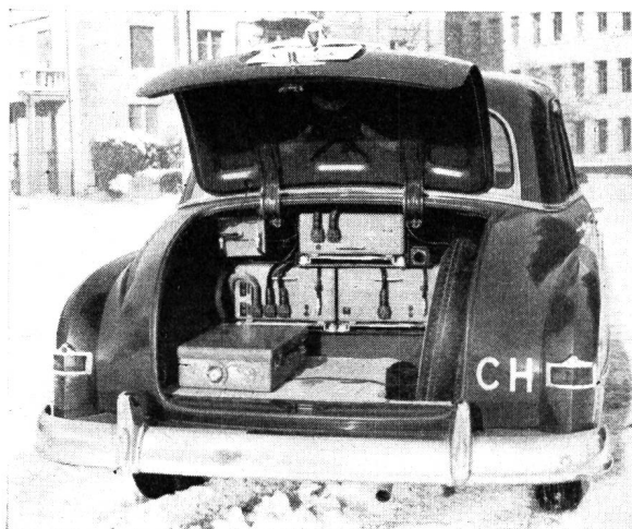
Fig. 3. Radiovox-Anlage, auf gefedertem Montagerahmen, im Kofferraum eines Wagens eingebaut
