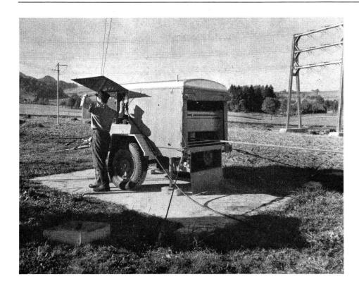
Fig. 7. Winde im Betrieb. Man beachte die Verankerung Treuil en action. Remarquer le haubanage
