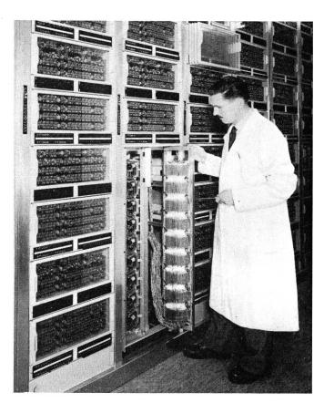
Fig. 3. Relais-Chassis und ausschwenkbarer 30iger-Sucherrahmen in Gestellreihen montiert
