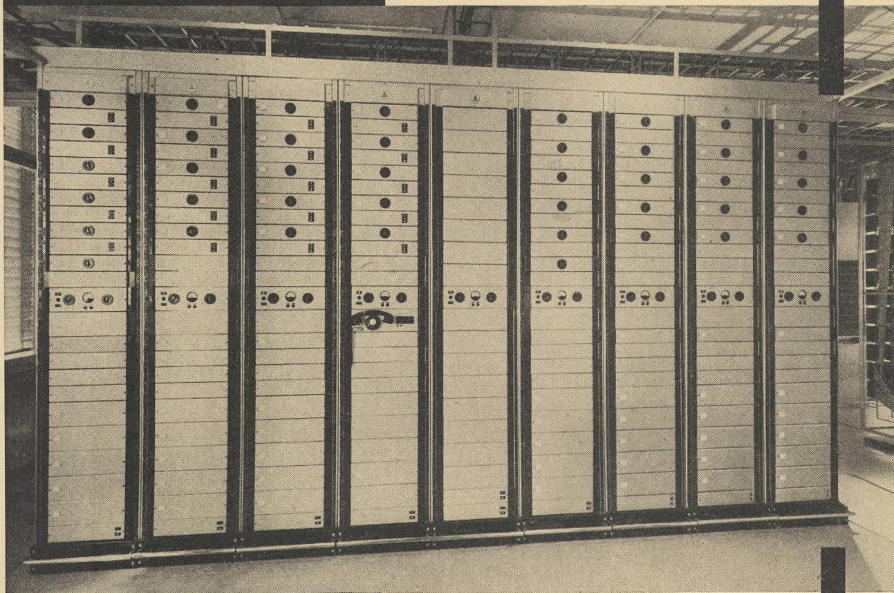
Ein Teil der Koaxial-Endausrüstung im Verstärkeramt Zürich, welche das Gotthard-Koaxialkabel mit dem Fernkabelnetz nördlich der Alpen verbindet. Konstruiert und fabriziert in unserem Werk Zürich.
