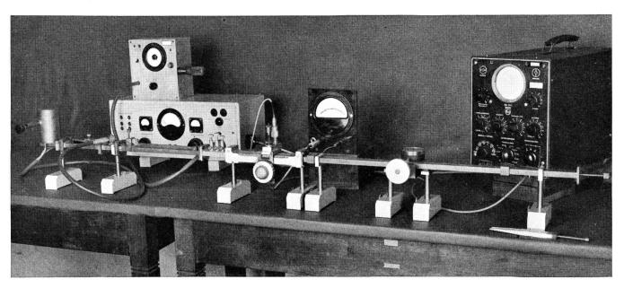
Fig. 2. Quetschleitung und Messplatz für 10000 MHZ ( $\lambda=3\,\mathrm{cm}$ ). Klystron 2K25, Abschwächer, Wellenmesser, Abschwächer, Anpassungstransformator, Messleitung, Quetschleitung, reflexionsfreier Abschluss
