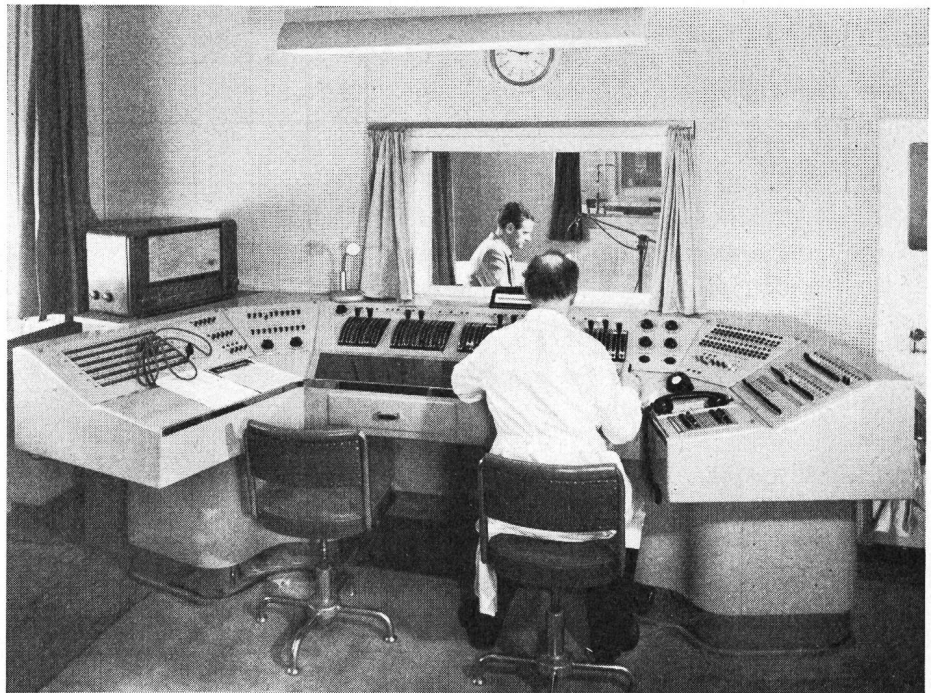
Fig. 1. Regiepult mit eingebauten Verstärkern, Schalt- und Kontrollorganen
