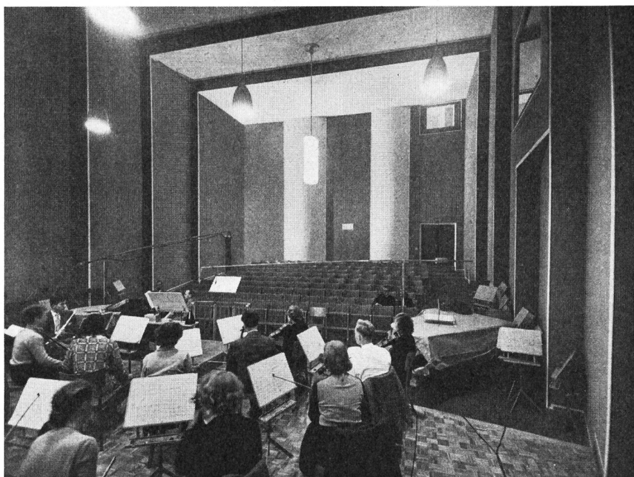
Fig. 8. Konzertstudio mit diffus reflektierenden Wänden
