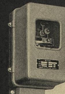
La longévité de vos accumulateurs dépend essentiellement de leur état de charge; le relais voltmétrique LG contrôle cet état et commande la charge automatiquement.
