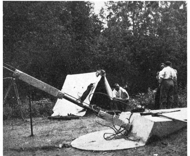
Fig. 9. Abspannung mit Verankerung Arrêtage avec ancrage
