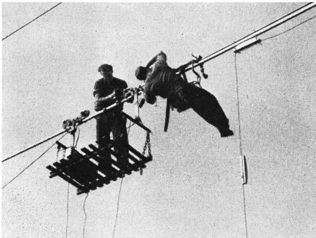
Fig. 15. Befestigung des Kabels vom Montagewagen aus
