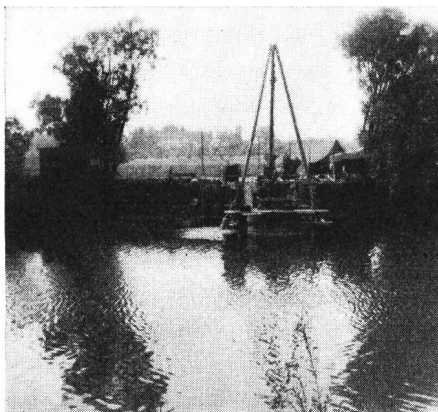
Fig. 3. Ansicht der Baustelle Vue du chantier
