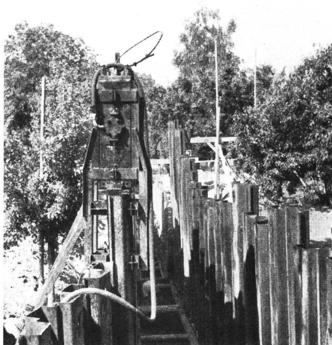
Fig. 18. Spundwände mit aufgesetzter Ramme (Payothammer)
