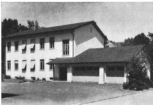
Fig. 1. Zweckbau der Telephonzentrale Wohlen (Aargau) Maison abritant le central téléphonique de Wohlen (Argovie)
