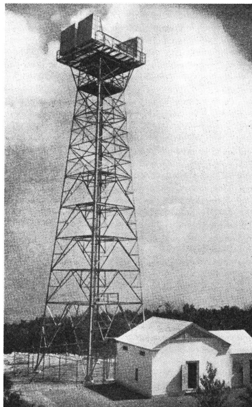
Fig. 21b. Verbindung New York–San Francisco. Antennenturm aus Stahl, Höhe 40 m
