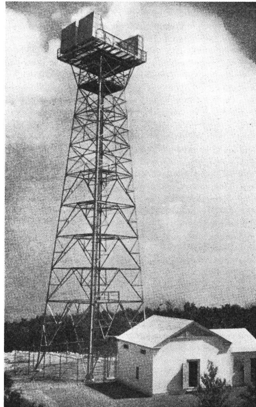
Fig. 21b. Verbindung New York-San Francisco. Antennenturm aus Stahl, Höhe 40 m
