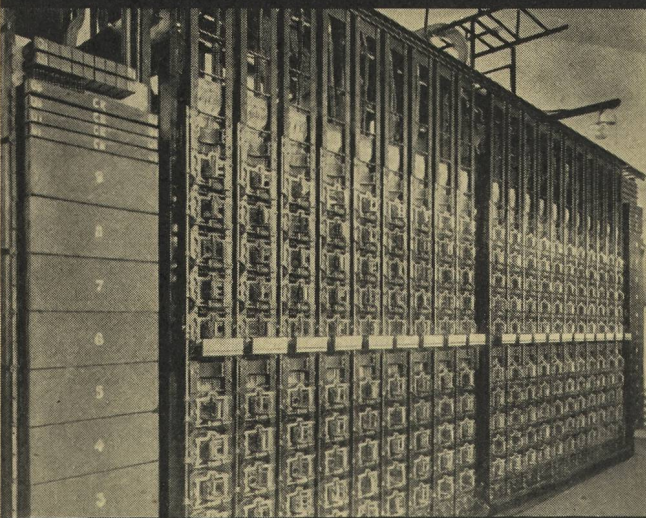
Oben: Ansicht einer Wählerreihe der neuen Ausrüstung in Hottingen I.
