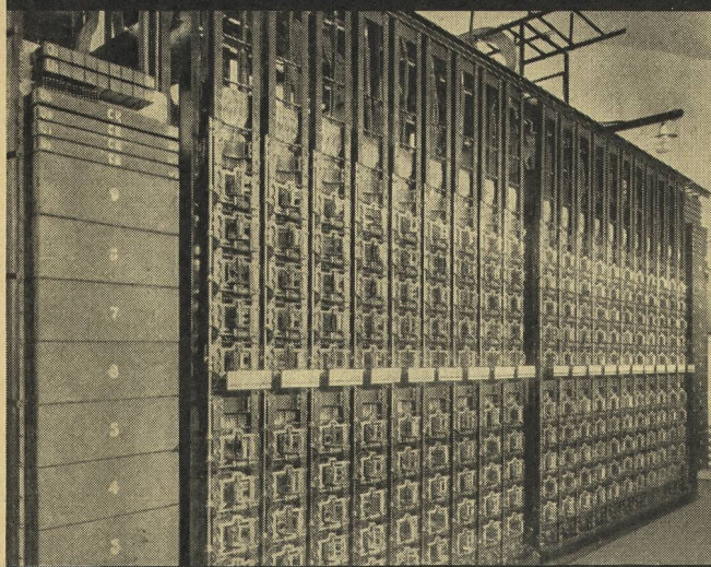
Oben: Ansicht einer Wählerreihe der neuen Ausrüstung in Hottingen I.
