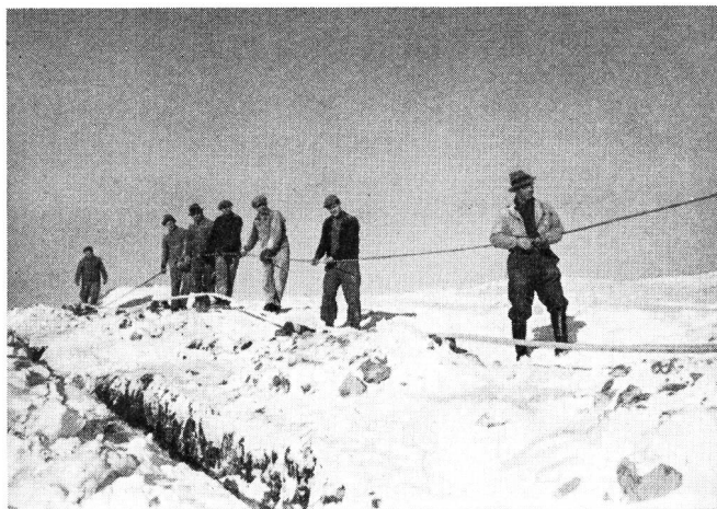
Fig. 10. Pose de câble dans la neige. Le câble coaxial est tiré sur des galets
