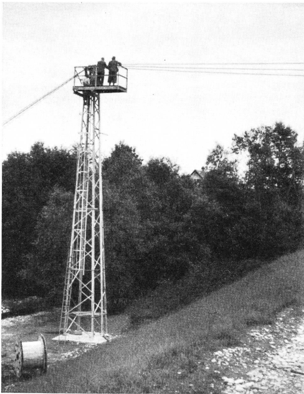
Fig. 13. Traversée aérienne du Rhin: un des pylônes
