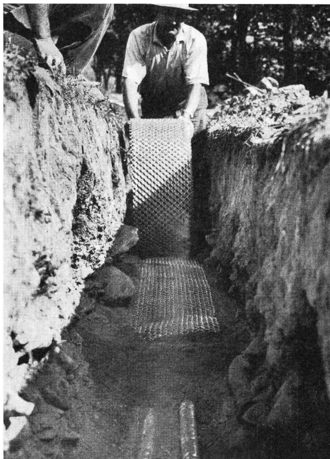
Fig. 11. Pose du câble. Le câble est recouvert d'un treillis
