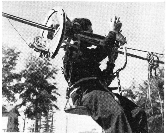
Fig. 14. La machine à enrouler le fil d'attache
