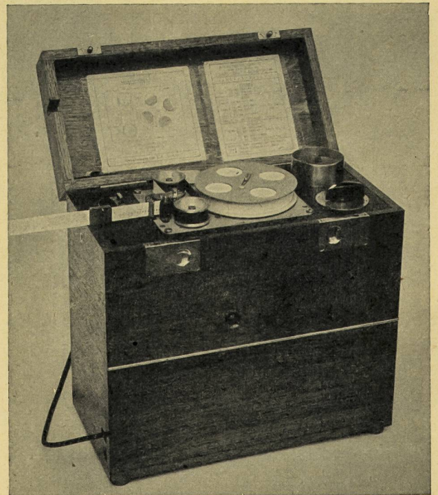
Apparat zur Kontrolle der Gesprächstaxierung
