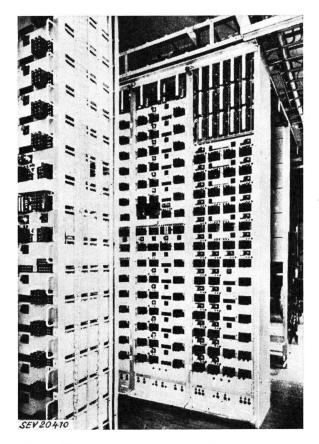
Fig. 5. Trägereinrichtung in einem Verstärkeramt
