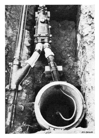
Fig. 1. Fernkabel mit Abzweigmuffe und Pupinschacht
