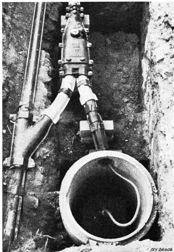
Fig. 1. Fernkabel mit Abzweigmuße und Pupinschacht
