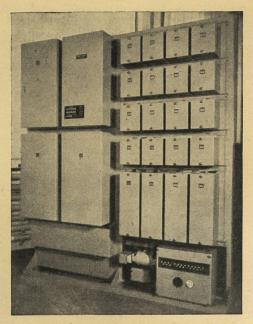
Automatische Telephonanlage auf der Grundlage des Kreuzwählerprinzips
