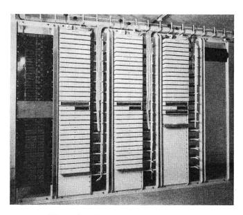
Fig. 6. Gestell mit den Schaltorganen Bâti des organes de connexion
