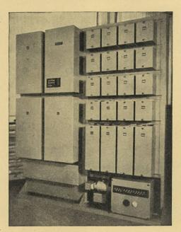
Automatische Telephonanlage auf der Grundlage des Kreuzwählerprinzips
