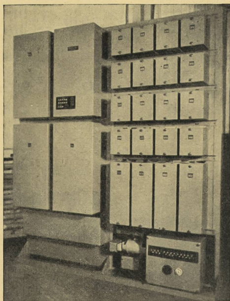
Automatische Telephonanlage auf der Grundlage des Kreuzwählerprinzips
