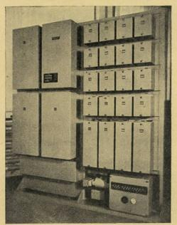
Automatische Telephonanlage auf der Grundlage des Kreuzwählerprinzips
