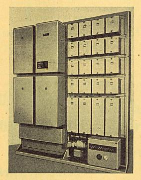
Telephonautomat auf der Grundlage des Kreuzwählerprinzips
