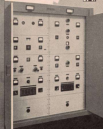
Zur Verbesserung der örtlichen Empfangsverhältnisse wurde in Basel ein neuer Stadtsender in Betrieb gesetzt. Er arbeitet mit der Frequenz von 1367 kHz und überträgt vollautomatisch das Programm von Beromünster.
