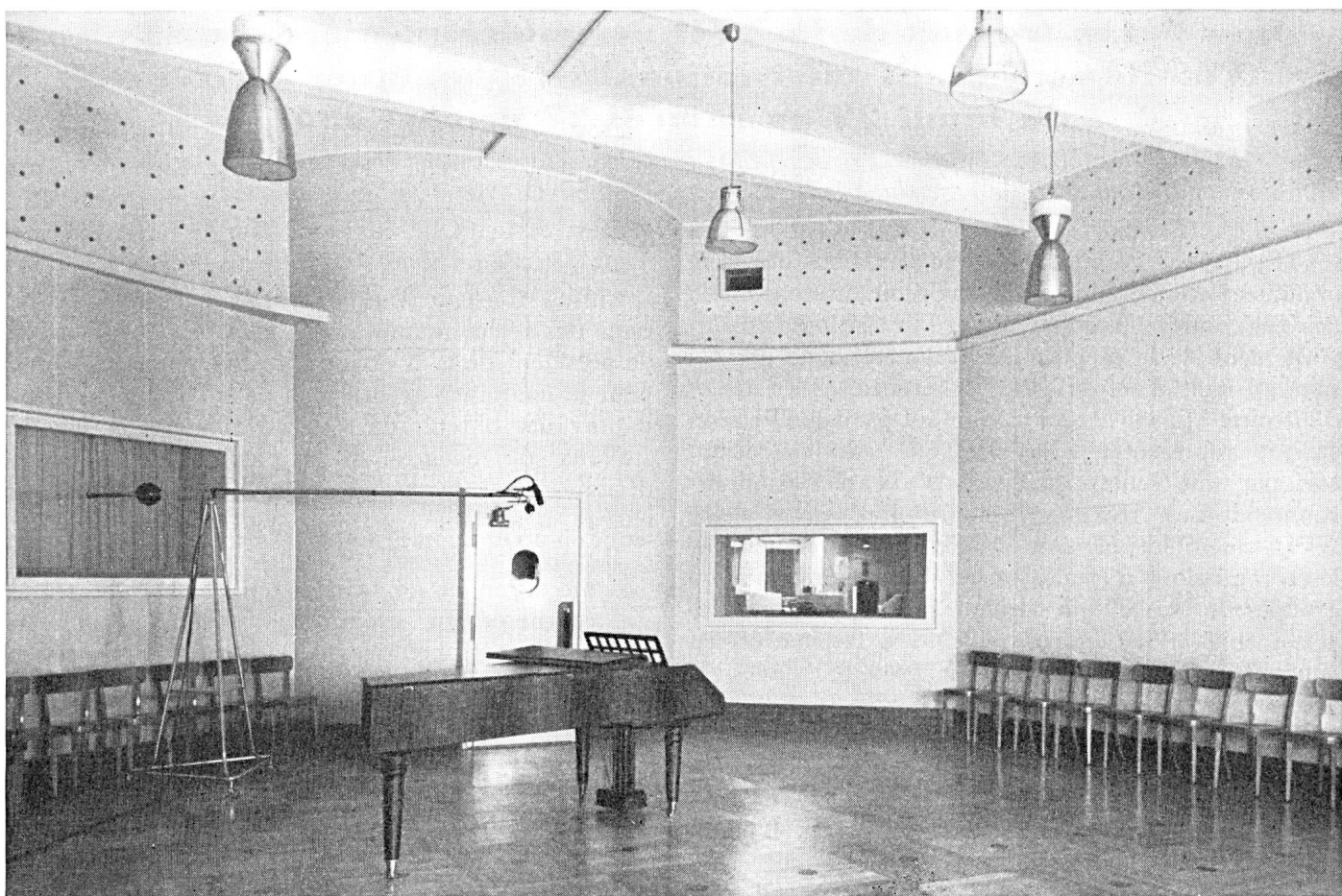
Fig. 5. Radiostudio in Zürich mit Helmholtzresonatoren aus Hohlkammersteinen Studio de radio à Zurich pourvu de résonateurs de Helmholtz en briques creuses
