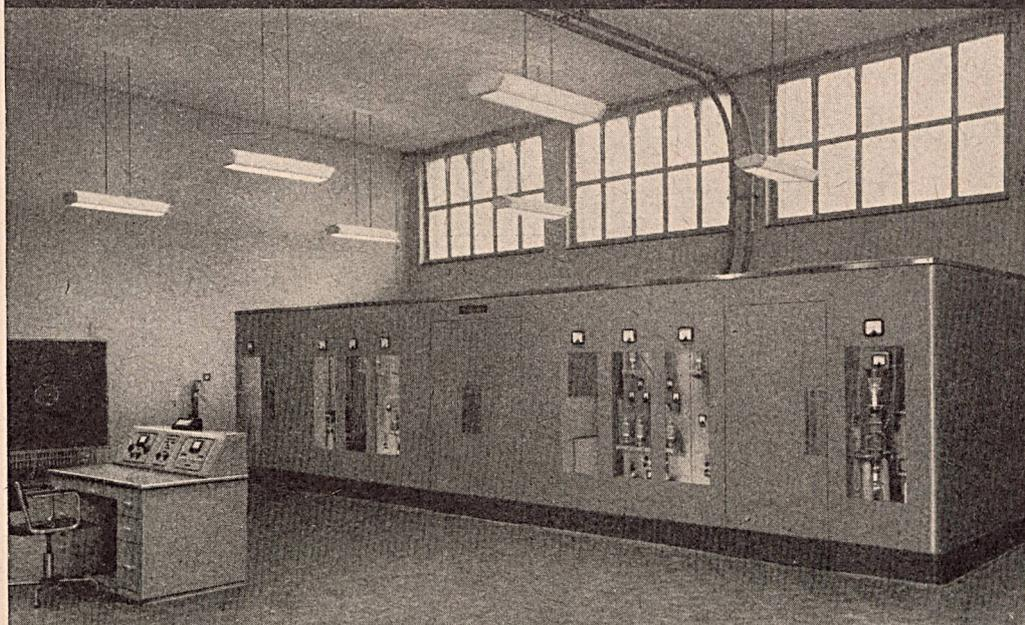
Betriebssicherheit ist die wichtigste Eigenschaft eines modernen Rundfunksenders. Beim Sender Sottens II sind Betriebsunterbrüche praktisch ausgeschlossen. Der Sender besteht aus 2 parallelgeschalteten Einheiten. Im Störfalle wird die betroffene Einheit automatisch ohne Betriebsunterbruch abgeschaltet.
