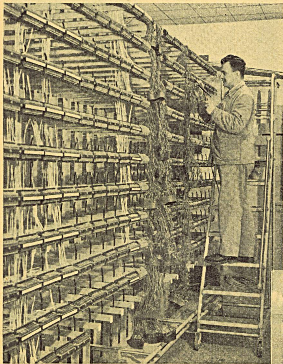
Montagearbeiten am Hauptverteiler während des Baues.
