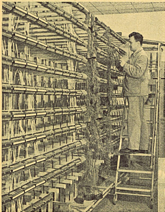
Montagearbeiten am Hauptverteiler während des Baues.
