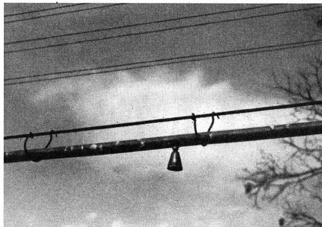
Fig. 22. Aération naturelle d'un câble aérien poreux
