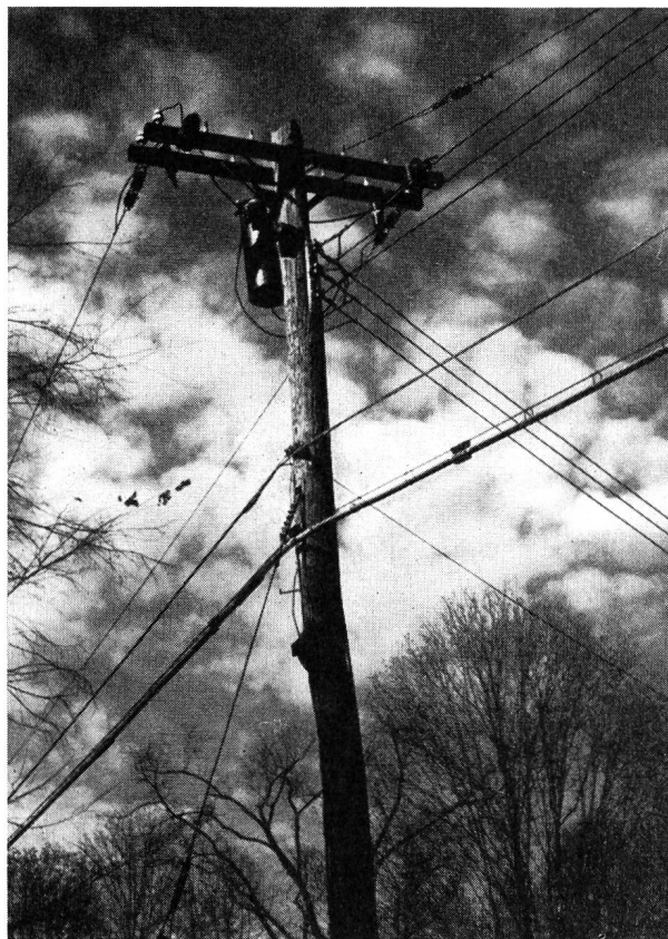
Fig. 15. Ligne à moyenne tension 2300 V, ligne de lumière 115 V et câble téléphonique sur le même poteau
