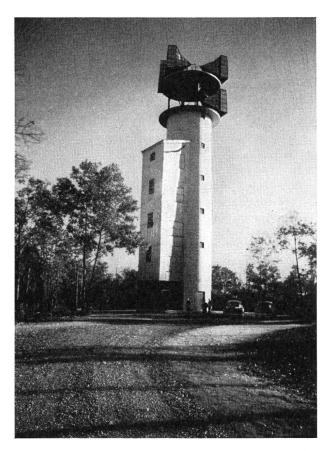
Fig. 2. Station-relais de la liaison par faisceaux hertziens New-York—Chicago à Martinsville, N. Y.
