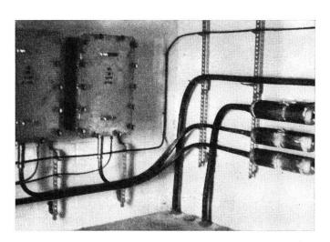
Fig. 9. Station de répéteurs pour câble coaxial (vue intérieure)
