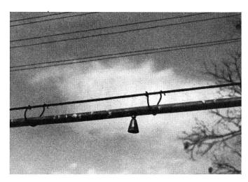
Fig. 22. Aération naturelle d'un câble aérien poreux
