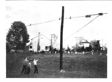
Fig. 19. Pose d'un câble aérien au moyen du «cable lasher»
