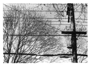
Fig. 16. Ligne 2300 V, ligne de lumière 115 V et câble téléphonique
