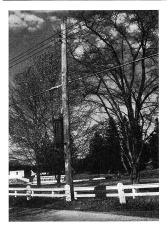
Fig. 14. Ligne de lumière 115 V et câble téléphonique aérien avec pot Pupin sur le même poteau
