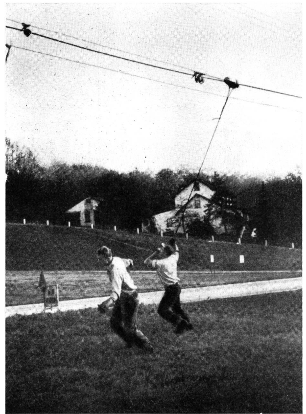
Fig. 18. Pose d'un câble aérien au moyen du «cable lasher»
