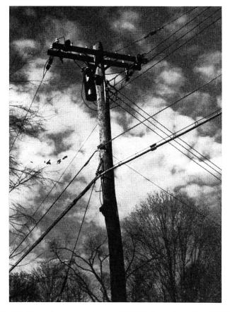
Fig. 15. Ligne à moyenne tension 2300 V, ligne de lumière 115 V et câble téléphonique sur le même poteau
