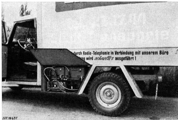
Fig. 5. Einbau der Apparate in einem Express-Camion der Firma Weltil-Furrer AG., Zürich
