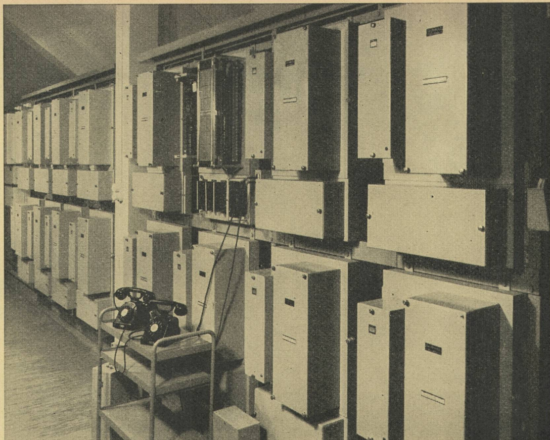
Gestellreihe mit Leitungsdurchschaltern
