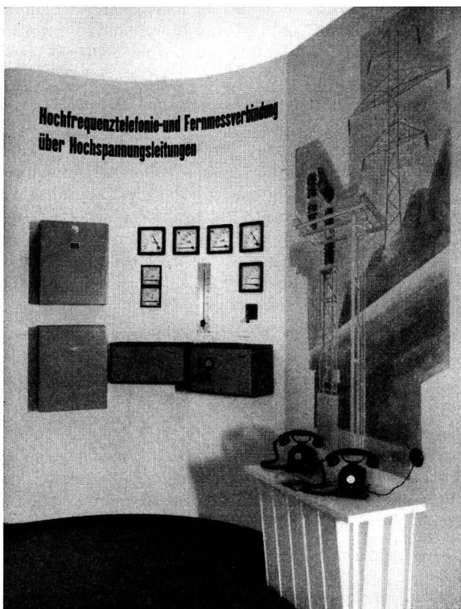
Fig. 1a. Schweizerische Mustermesse, Basel 1951. Vorführungsanlage Brown Boveri für Träger auf Hochspannungsleitungen. Fernmess-Sendeseite
