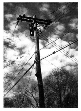
Fig. 15. 2300-V-Mittelspannung, 115-V-Lichtleitung und Telephonkabel auf dem gleichen Gestänge
