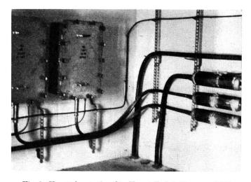
Fig. 9. Verstärkerstation für Koaxialkabel (Innenansicht)
