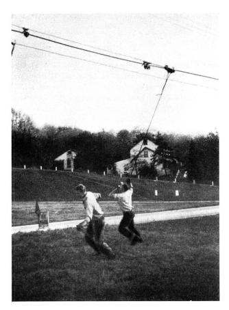
Fig. 18. Verlegung eines Luftkabels mit dem «cable lasher»
