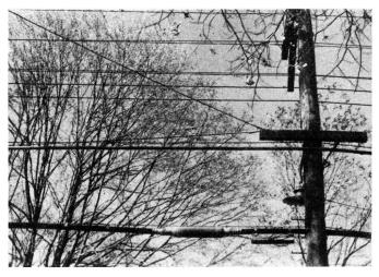
Fig. 16. 2300-V-Leitungen, 115-V-Lichtleitungen und Telephonkabel
