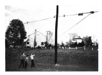
Fig. 19. Verlegung eines Luftkabels mit dem «cable lasher»
