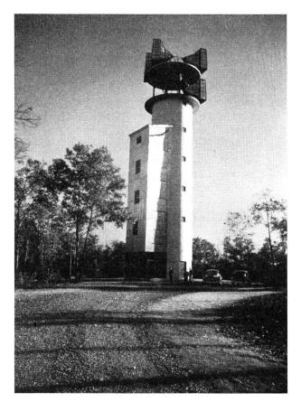
Fig. 2. Relaisstation der Richtstrahlverbindung New York-Chicago in Martinsville, N. Y.
