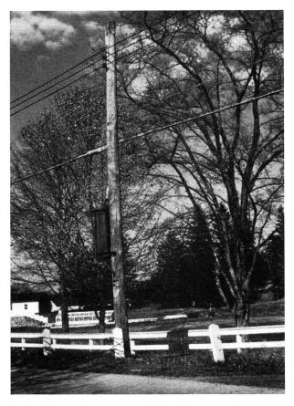
Fig. 14. 115-V-Lichtleitung und Telephon-Luftkabel mit Pupintopf auf dem gleichen Gestänge
