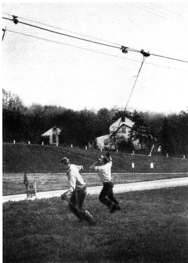
Fig. 18. Verlegung eines Luftkabels mit dem «cable lasher»
