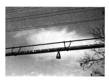
Fig. 22. Natürliche Belüftung eines undichten Luftkabels
